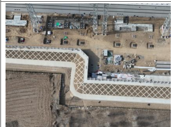
大同变电站框格植草护坡 (2026.3.16)
