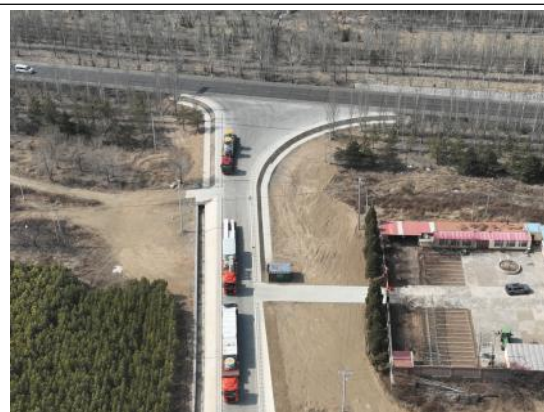
大同变电站进站道路排水沟 (2026.3.16)
