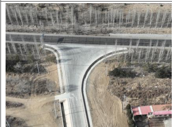
大同变电站进站道路排水沟 (2026.1.19)
