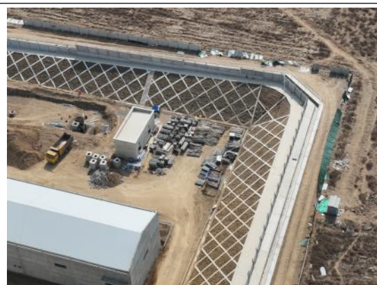
大同变电站框格植草护坡 (2026.3.16)
